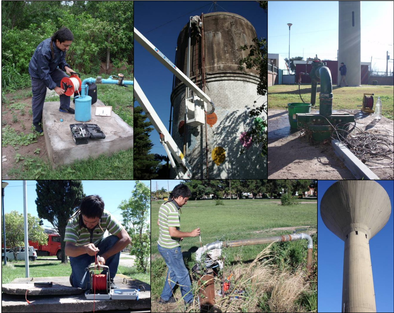
Figura 8.16 Mediciones de niveles estáticos y toma de muestra en pozos y perforaciones que explotan el SAC A para abastecimiento público de agua potable.
