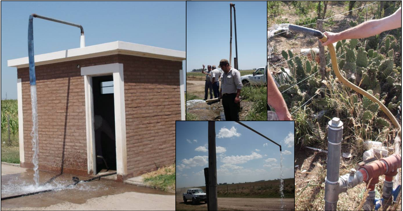
Figura 8.14 Perforaciones surgentes del SAC D, con caudales de surgencia que varían desde 1 hasta 25 m 3 /h. Ubicadas entre las localidades de la Tordilla, Colonia de las Pichanas y Tio Pujio, Realizadas por la empresa perforadora Renz. Quien ha facilitado datos.
