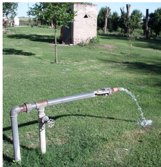
Figura 9.10 Perforación surgente de la zona norte de la localidad La Tordilla. SAC D
