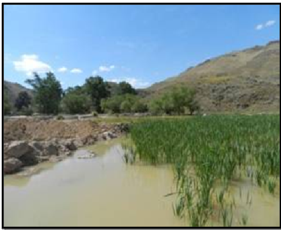
C) Piletas de decantación (Piletas)
