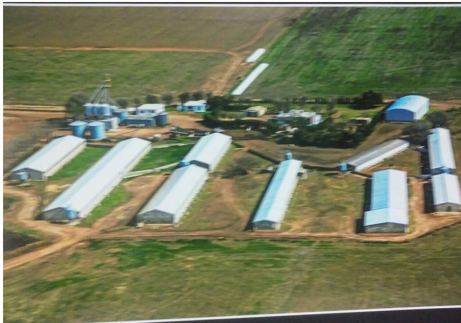
Imagen 8. Vista aérea del establecimiento
