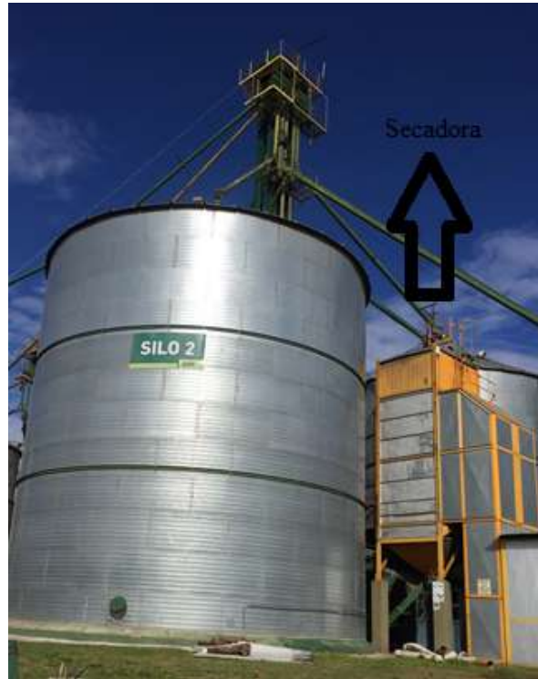
Figura AI.1: Uno de los dos silos de almacenamiento de soja y secadora.
