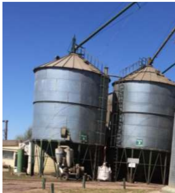
Figura AI.2: Dos de los 4 tanques pulmón que alimentan a las líneas de producción.
