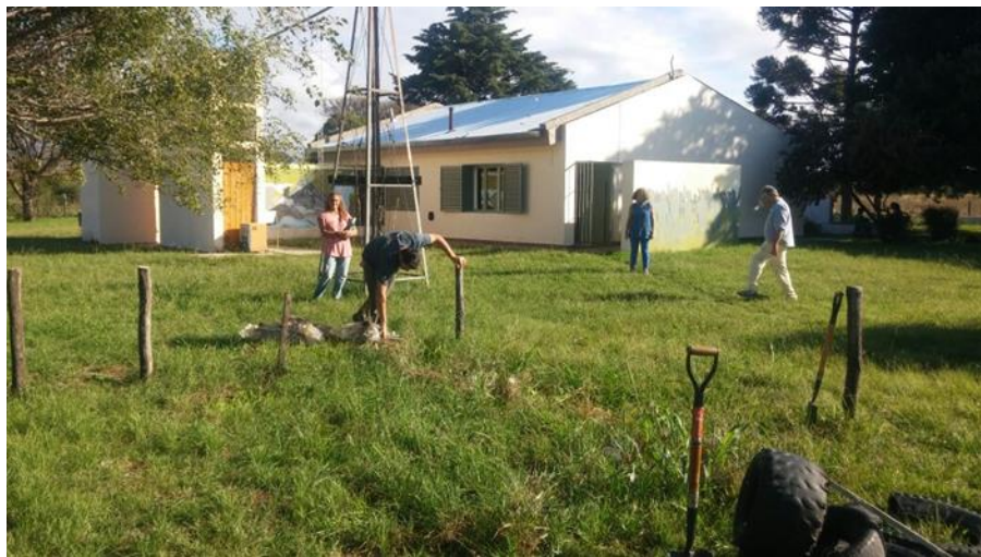
FIGURA 7: Limpieza del terreno.
