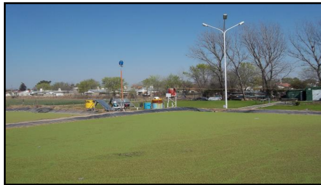
Figura 3. 1º y 2º laguna con macrófitas. Planta Piloto UNRC. Río Cuarto. Córdoba.
