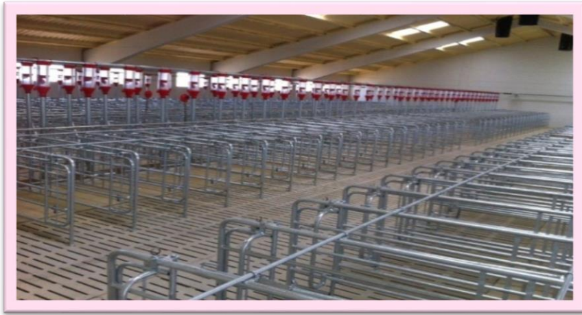
Figura 27: Granja de nueva construcción con compuerta giratoria
