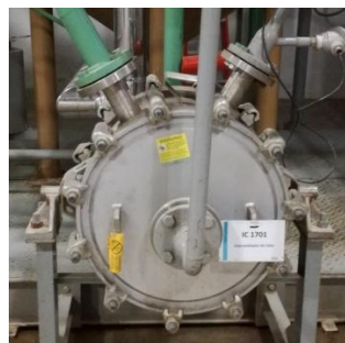
Imagen 5. Intercambiador de calor en espiral
