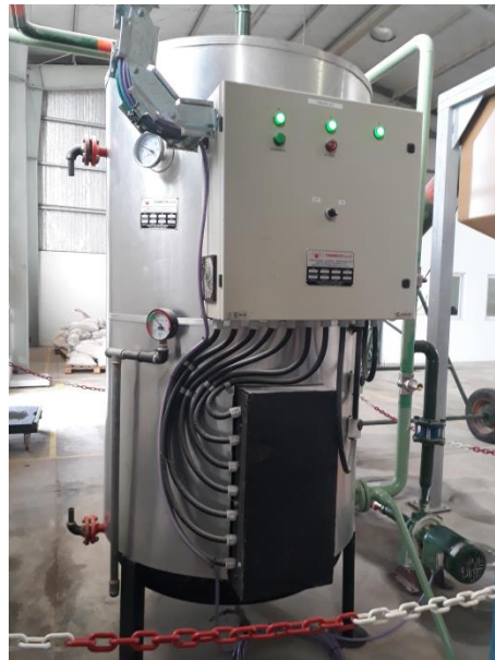
ILUSTRACIÓN A1.1 CALENTADOR ELÉCTRICO (CL1701)
