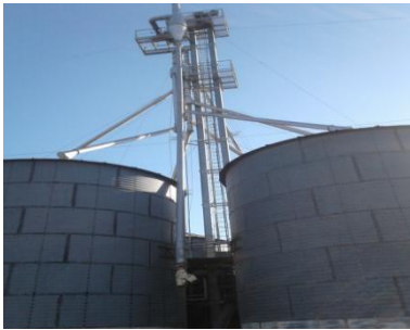
Figura 3: Noria externa y silos de almacenamiento
