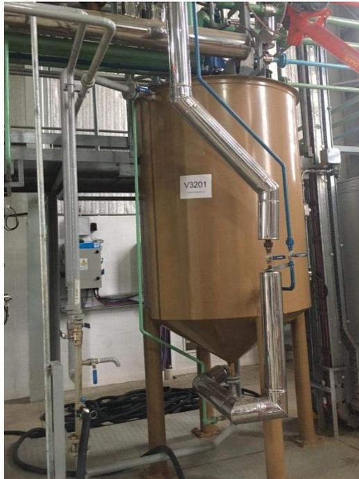
*Figura AI. 5 Tanque de pre-mezcla y licuefacción*
