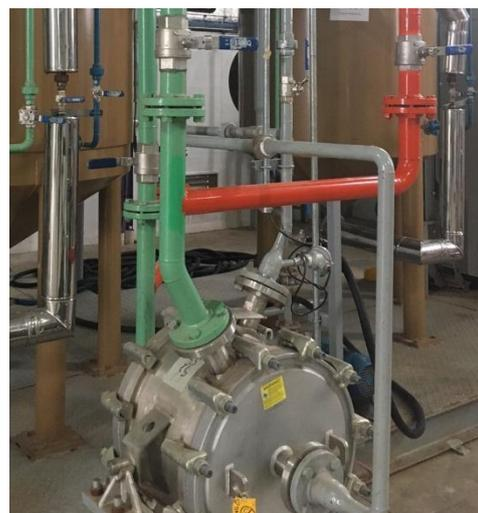
Figura AI. 4 Intercambiador de calor
