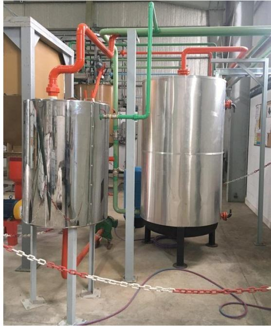
Figura AI. 2 Calentador eléctrico y tanque pulmón
