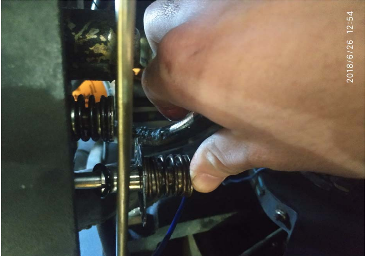
g- Cambio de topes desgastados en válvula de distribuidor hidráulico
