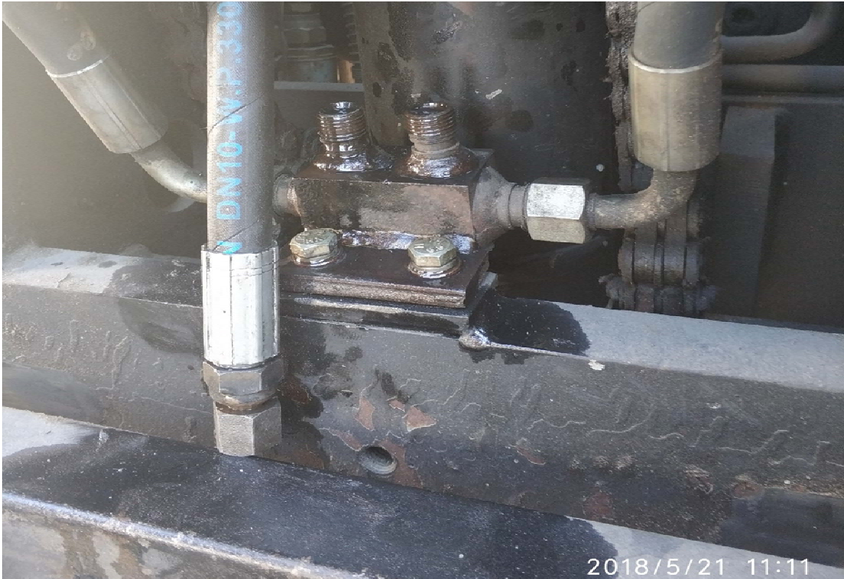
c- Cambio de mangueras hidráulicas desgastadas en Auto elevador a combustión
