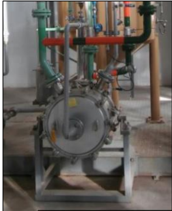
Figura A3.5: Intercambiador de calor en espiral
