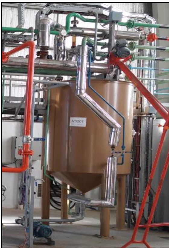
Figura A3.6: vista frontal y superior del Tanque pre-mezcla y licuefacción (V3201)
