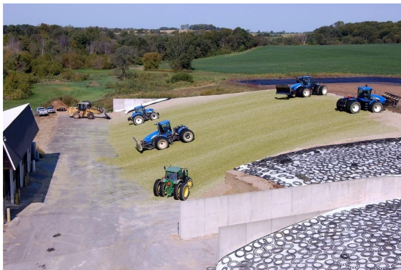
Figura 8: Elaboración de silo bunker.
