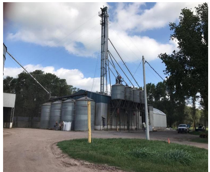
Figura N° 2: Exterior de fábrica de alimento
