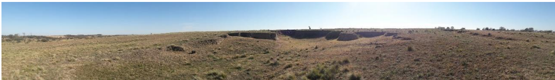
Figura 23: vista de la cabecera de una cárcava en unidad RC.
