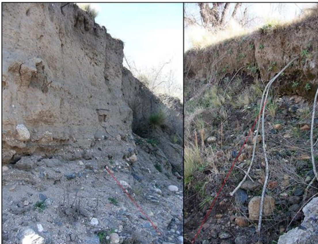
Figura V.5: Material psefítico que constituye las márgenes, que se incorpora al canal. Nótese el talud de derrubios próximos al cauce (línea roja).
