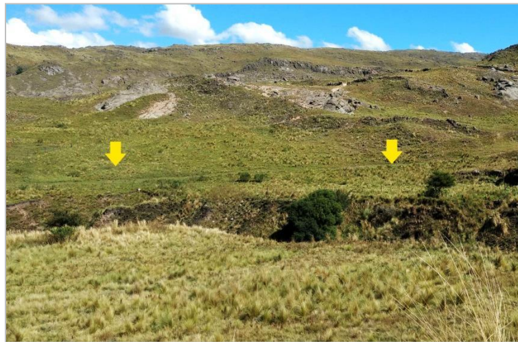
Figura IV.27. Taludes con cubierta coluvial.
