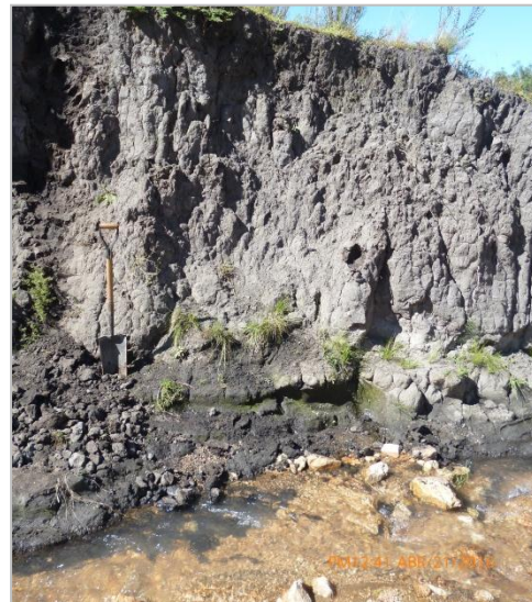
Figura VIII.19. Desprendimiento de material del almacenamiento tipo 6, el cual es incorporado al canal
