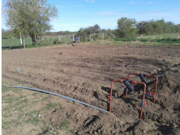
Imágen 3. Instalación del equipo de riego por goteo subterráneo. Planta Piloto UNRC.
