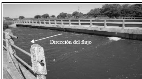
Figura 5.6. Sección de medición en el Río Saladillo sobre el puente de ruta provincial 6. Se observa la altura de agua alcanzada por el río durante la crecida de marzo de 2015 (Extraído de Lozada et al. 2015)
