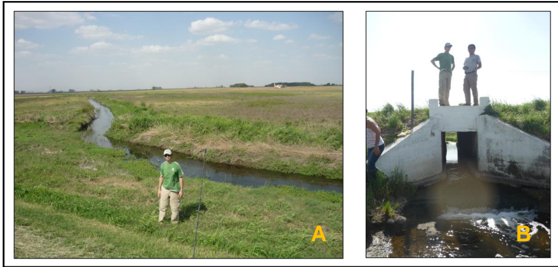
Figura 5.8. Canal y su sección de aforo en alcantarilla al costado de la ruta 12.
