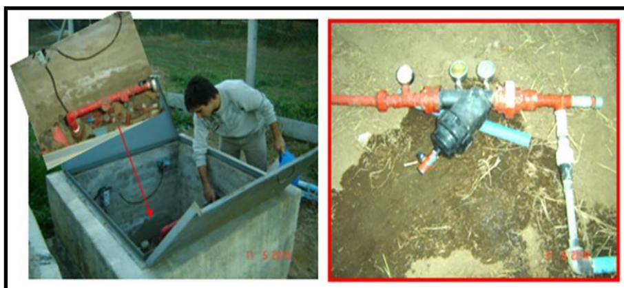
Figura 7. Equipo de bombeo y centro de control de riego. Planta Piloto UNRC. Río Cuarto. Córdoba.
