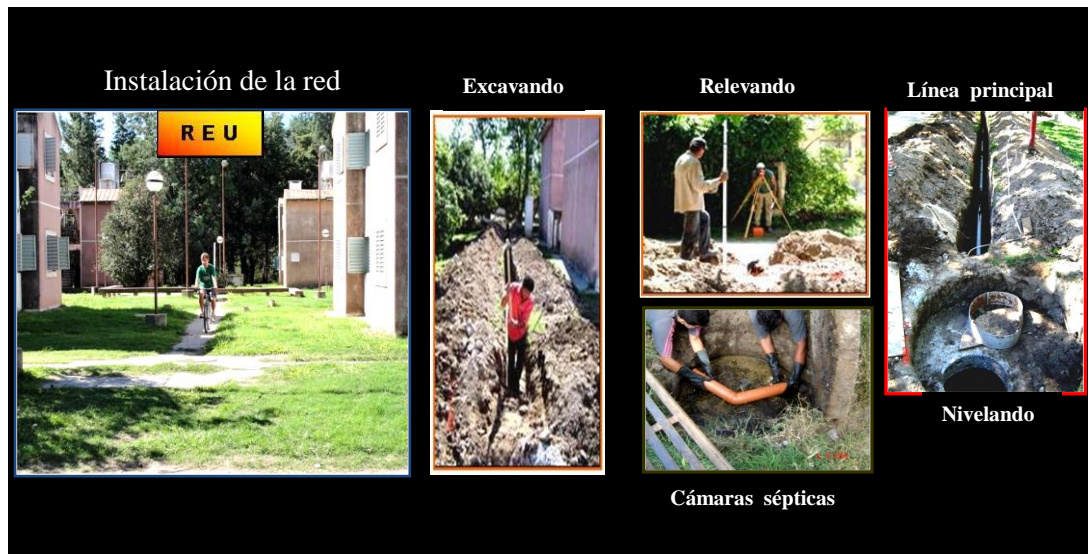
Figura 1: REU y trabajos previos de interconexión cloacal. UNRC. Río Cuarto. Córdoba.
