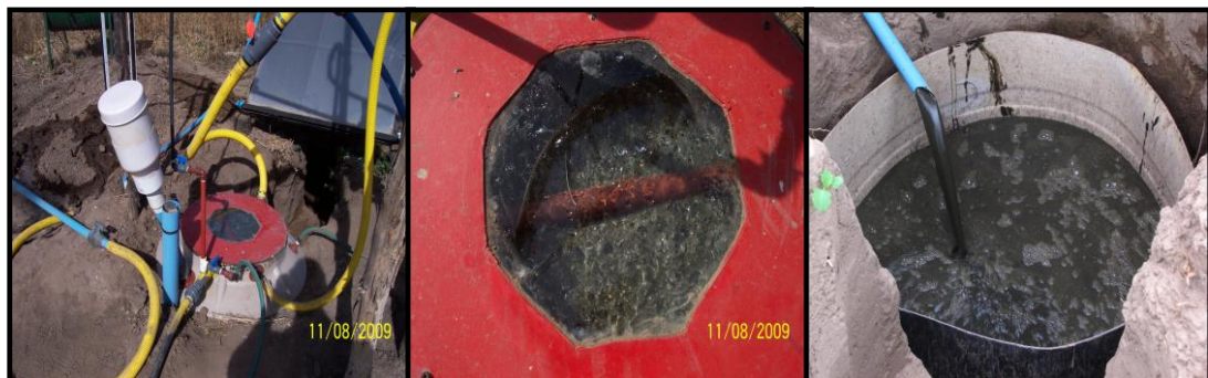
Figura 6: Biodigestor vertical y descarga de biosólidos. UNRC. Río Cuarto. Córdoba.
