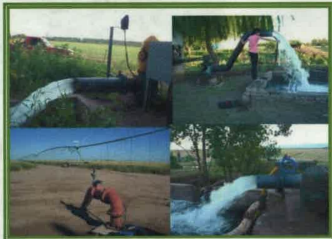
Figura 10.9. Captaciones más profundas y de mayor caudal.
