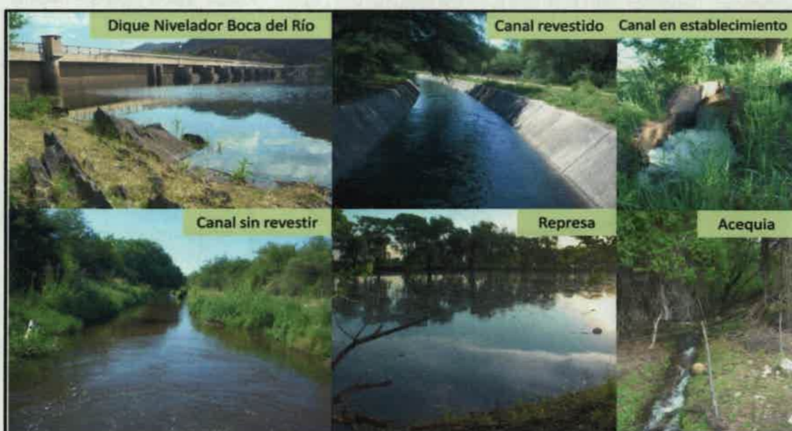
Figura 9.2. Sistema de canales provenientes del dique nivelador Boca del Río, que almacena agua del río de Los Sauces.
