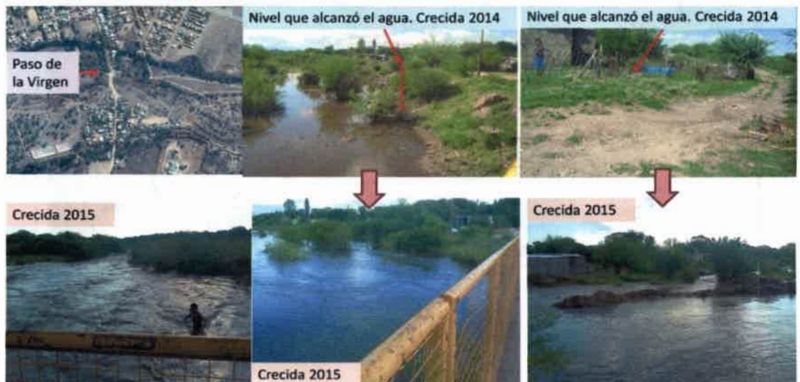
Figura 11.28. Sector del puente Paso de la Virgen. Detalle del albardón realizado para evitar el ingreso de agua a la zona urbanizada y comparación de los niveles alcanzados durante la crecidas de febrero de 2014 y febrero/marzo 2015.
