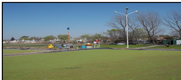
Figura 3. 1º y 2º laguna con macrófitas. Planta Piloto UNRC. Río Cuarto. Córdoba.
