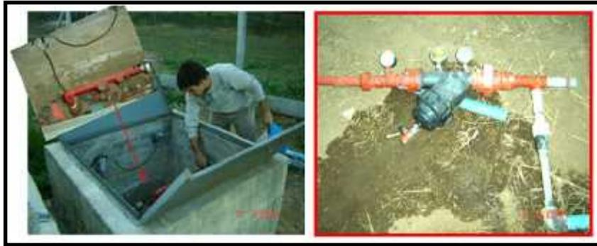
Fotografía 5. Equipo de bombeo y cabezal de riego. Planta Piloto UNRC.
