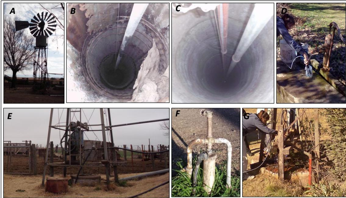
**Figura 6.25:** A- Molino con antepozo calzado. B- Antepozo de molino calzado en la parte superior con chapas en mal estado, y descalzado en la parte inferior. C- Antepozo de molino calzado con calzadas de cemento. D- Bomba manual. E- Perforación con bombeador. F y G- Perforación con electrobomba sumergible
