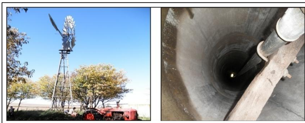
Figura 6.17: Ejemplos de perforaciones censadas con molino y antepozo calzado.
