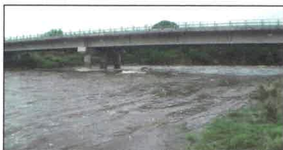
Figura III.7.74. Vista del río Las Cañitas, estación 13 (Fig. III.5.3), crecida 14/02/14.
