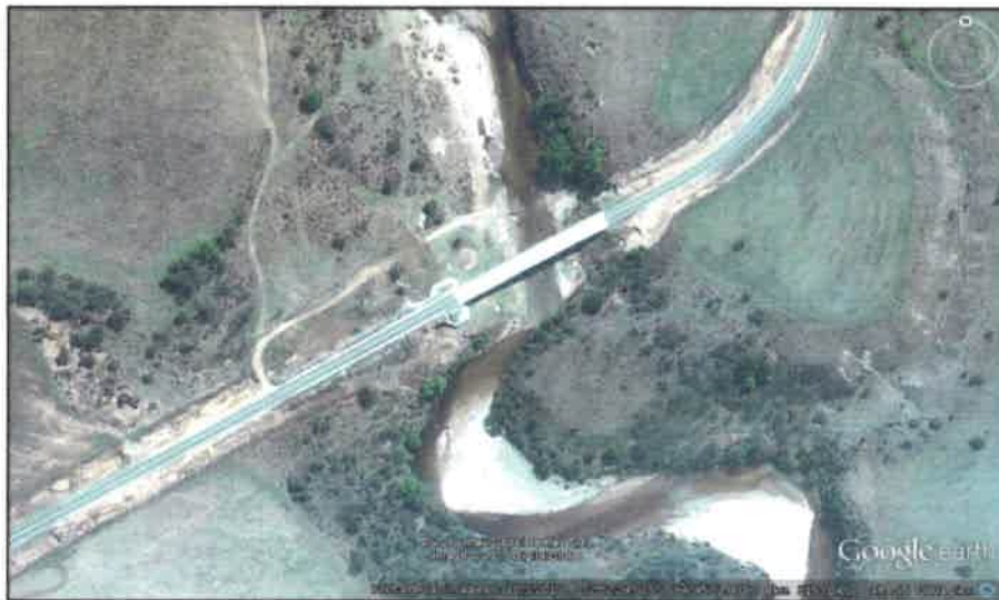
Figura III.8.6. Puente sobre el río Las Cañitas, puede observarse el importante estrechamiento de la sección aguas abajo del mismo.
