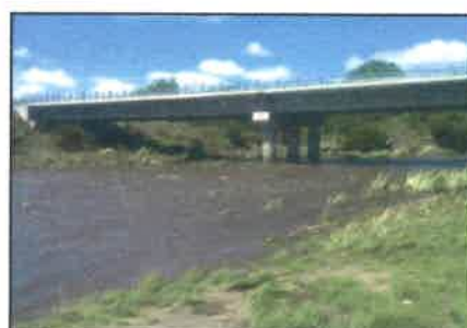
Figura III.7.75. Vista del río Las Cañitas, estación 13 (Fig. III.5.3), crecida 22/02/14.
