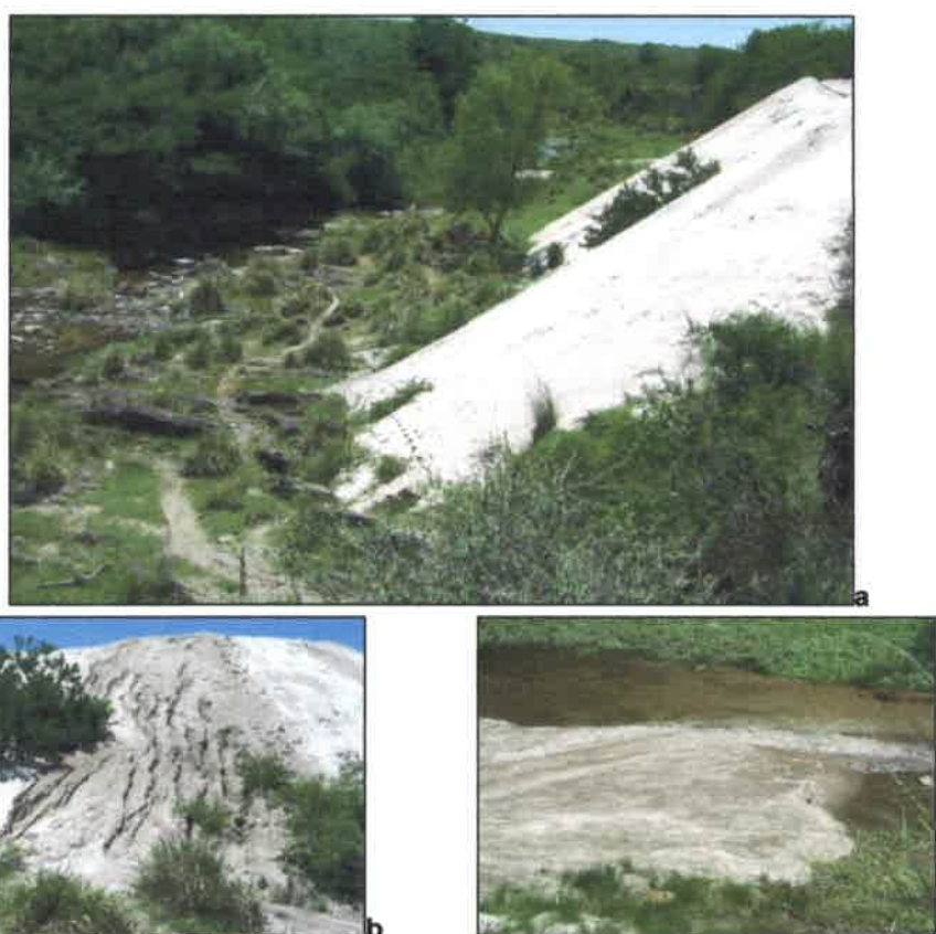
Figura V.7. a) Escombrera vinculada a la actividad minera de cuarzo dispuesta en proximidades del río Las Tapias (estación limnigráfica). b) Procesos erosivos en escombreras y c) Llegada al río de los materiales.
