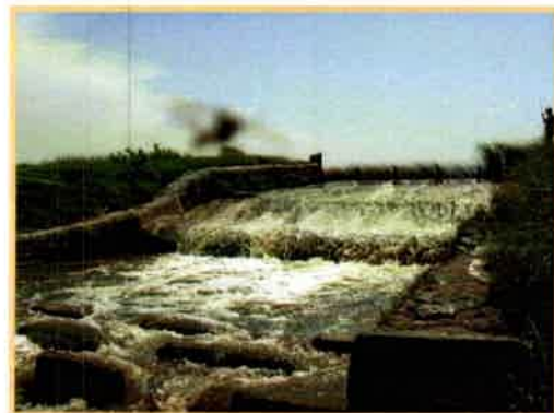
Figura 6.4. Sección de aforo del arroyo Chucul a la salida de la laguna Pagliero del sistema lagunar La Felipa (IA2).
