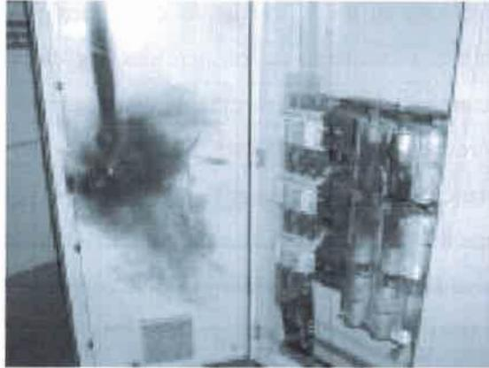
Figura 2.19. Efecto de una sobrecarga producida por un problema de resonancia
