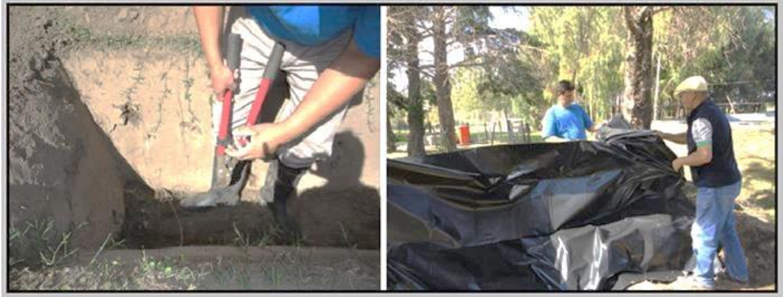
Figura 11. Impermeabilización con PE de media densidad.
