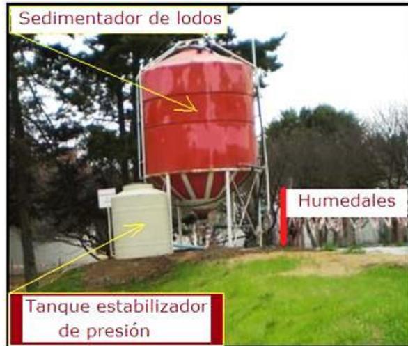
Figura 23. Instalación de tanque estabilizador de presión.
