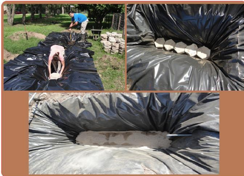
Figura 12. Colocación de adoquines y base de arena.
