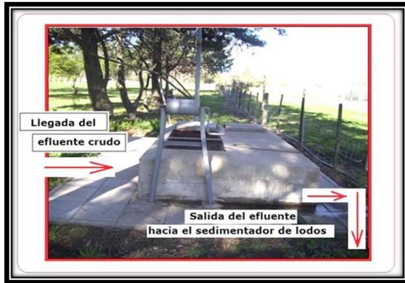
Figura 3. Cámara receptora de efluentes Planta Piloto de Tratamiento y Reutilización de Efluentes Urbanos de la UNRC.
