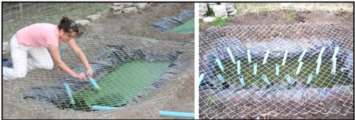
Figura 17. Procedimiento de instalación de los tutores hidráulicos.
