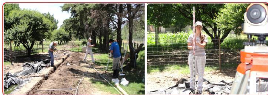
Figura 10. Relevamiento planialtimétrico de la línea de humedales.
