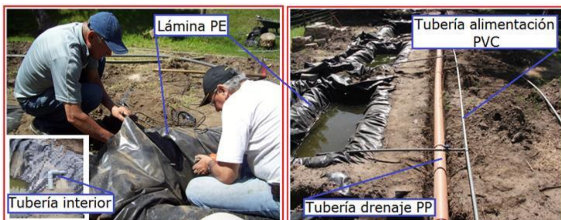
Figura 14. Red de tuberías de carga y descarga.
