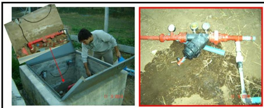
Figura 7. Equipo de bombeo y cabezal de riego. Planta Piloto UNRC. Río Cuarto. Córdoba.
