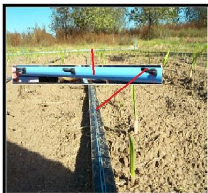
Figura 8. Línea secundaria y laterales de riego por goteo. Planta Piloto UNRC. Río Cuarto. Córdoba
