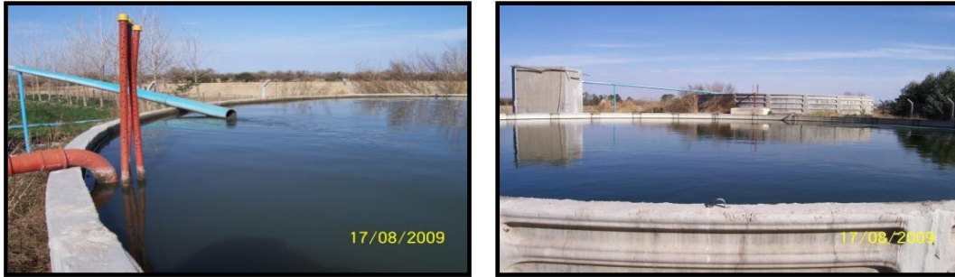
Figura 3: Sistema de tratamiento de efluentes. UNRC. Río Cuarto, Córdoba.
