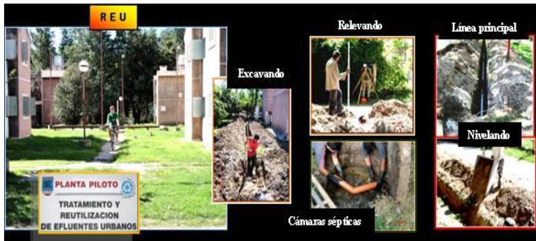
Figura 1. REU y trabajos previos de interconexión cloacal. UNRC. Río Cuarto. Córdoba.
