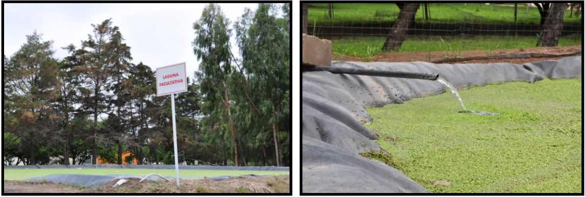
Figura 4. Tratamiento no convencional de los efluentes. Planta Piloto UNRC. Río Cuarto. Córdoba.
