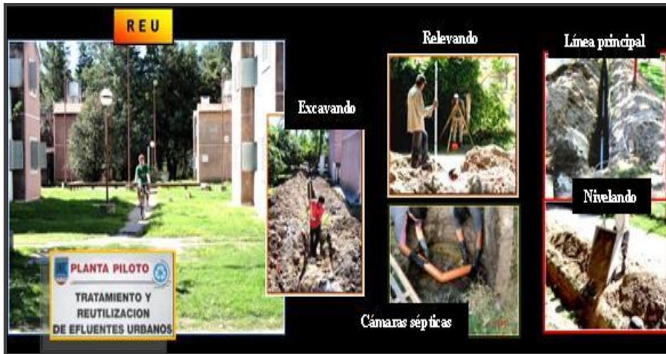
Figura 2. REU y trabajos previos de interconexión cloacal. UNRC. Río Cuarto. Córdoba.
