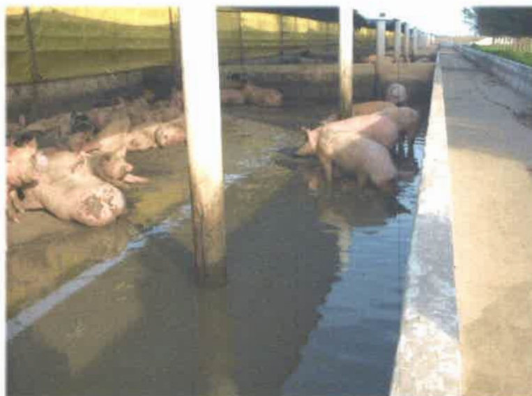
FIGURA N° 13. PISTA DE FRENTE ABIERTO TECHADA CON SLAT DE CEMENTO INTERNO Y PATIO EXTRENO DE PISO SÓLIDO, EN DONDE PUEDE OBSERVARSE ACUMULACIÓN DE AGUA Y MATERIA FECAL.
