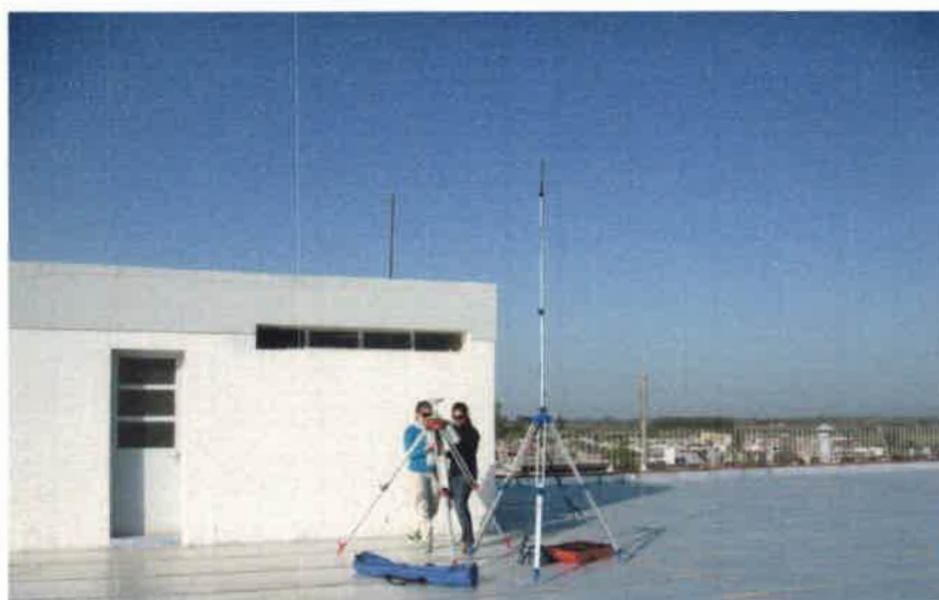
Foto 4.8. Instalación de Estación Base en terraza FCA-UNL, Esperanza
