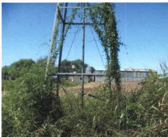
Foto 4.6. Molino sin acceso por presencia de malezas
