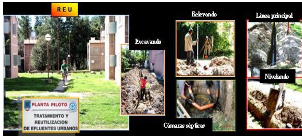
Figura 2. REU y trabajos previos de interconexión cloacal. UNRC. Río Cuarto. Córdoba.
