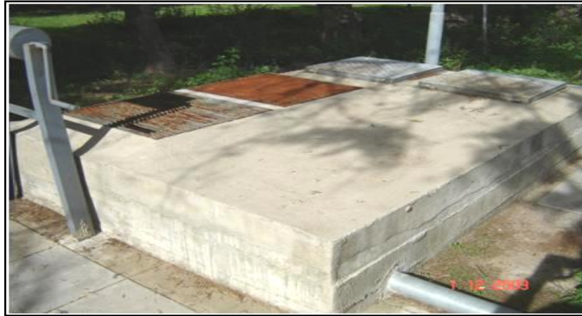
Figura 3: Vista en planta de la cámara concentradora de efluentes. UNRC. Río Cuarto. Córdoba.
