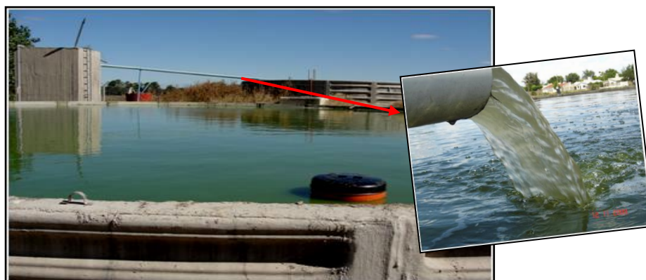
Figura 5: Planta convencional de tratamiento de efluentes. UNRC. Río Cuarto. Córdoba.
