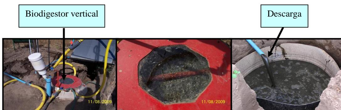
Figura 4: Biodigestor vertical y descarga de biosólidos. UNRC. Río Cuarto. Córdoba.
