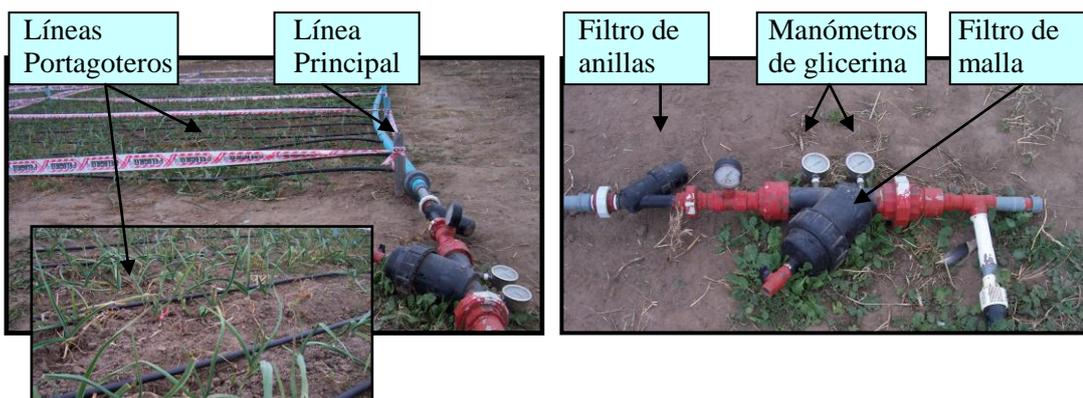
Figura 5: Líneas portagoteros, línea principal y detalle del cabezal de riego. UNRC. Río Cuarto. Córdoba.
