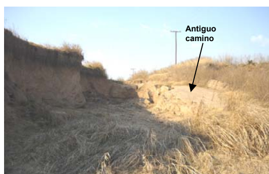
Foto V.16.: Camino inhabilitado por erosión.
