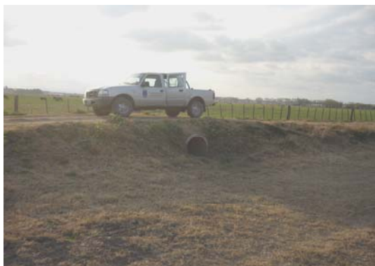
Foto V.13.: Entubamiento del arroyo San Francisco ubicado inmediatamente aguas abajo del primer tramo canalizado.
