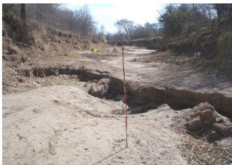
Foto V.5.: Vista aguas arriba del arroyo San Antonio en estación (8).
