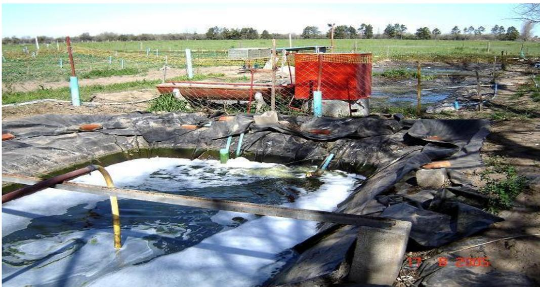
Figura 4: Lagunas de maduración para el tratamiento de las aguas residuales. UNRC, Río Cuarto. Córdoba. Argentina. Fuente: (Crespi, *et al.*, 2003).
