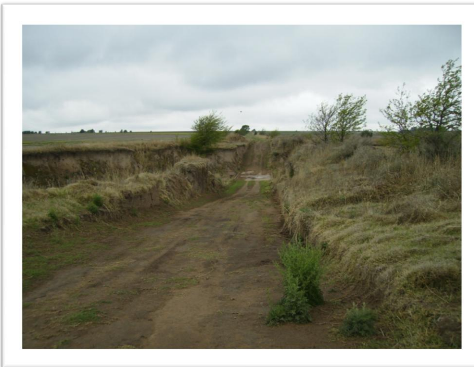
Figura Nº 8.1.b.: Caminos profundizados que actúan como colectores, con erosión retrocedente hacia predios agrícolas.
