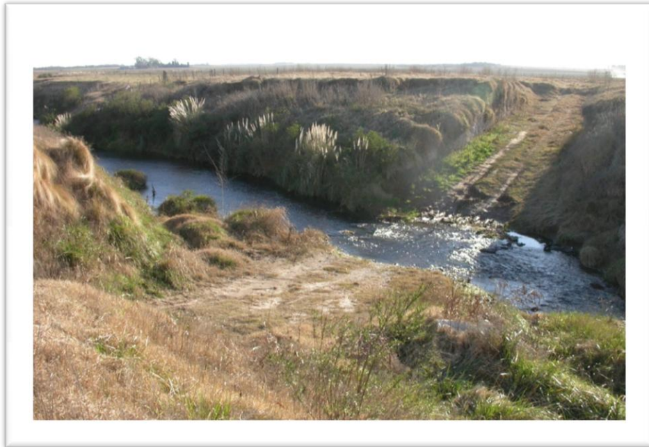
Figura Nº 8.1.a.: Vista del Arroyo La Colacha
