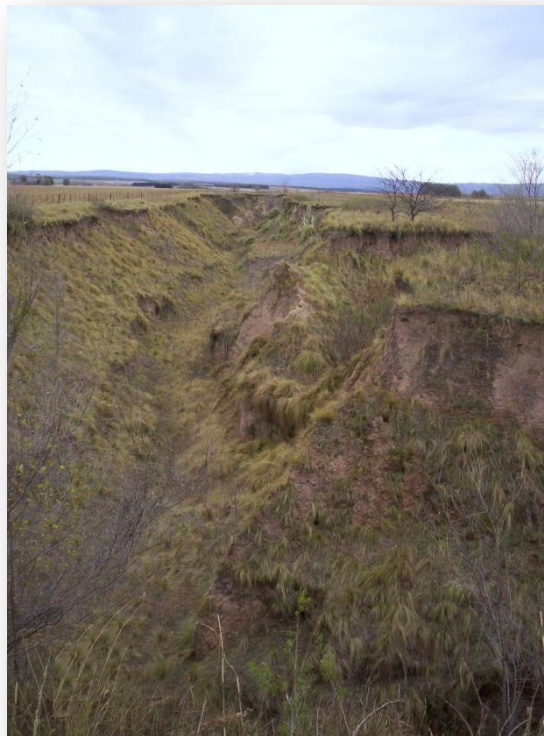
Figura N° 6.1.3: Tierras Improductivas. Desarrollo de cárcava.
