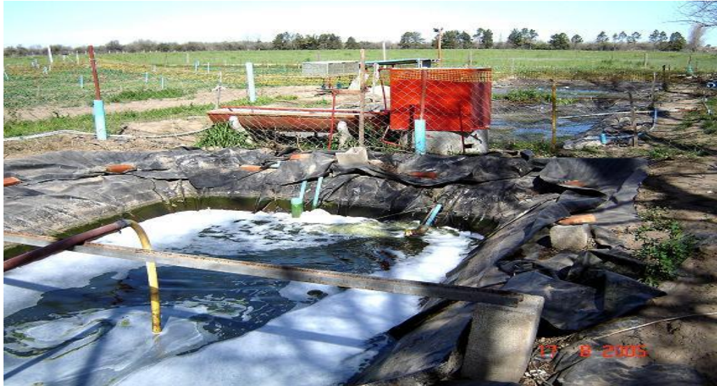
Figura 4: Lagunas de maduración para el tratamiento de las aguas residuales. UNRC, Río Cuarto. Córdoba. Argentina.
