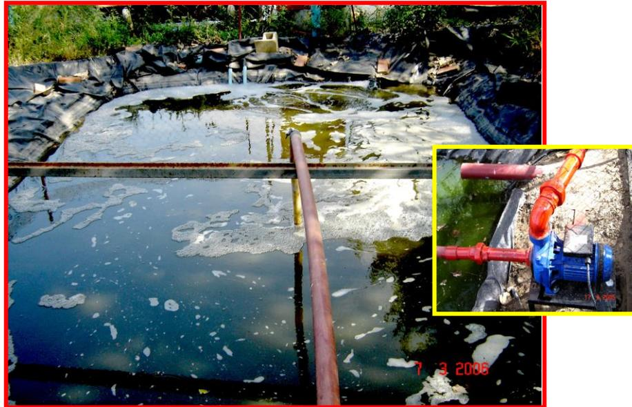
Figura 2. Tratamiento del agua residual en un reactor biológico. UNRC. Río Cuarto. Córdoba
