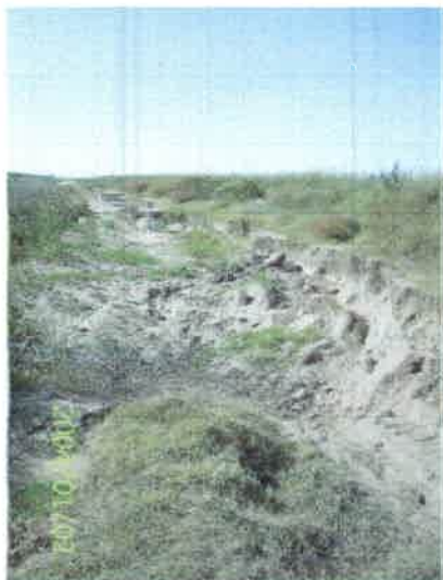
Figura 4.3: Cárcavas sobre camino rural en la zona de Coronel Moldes.
