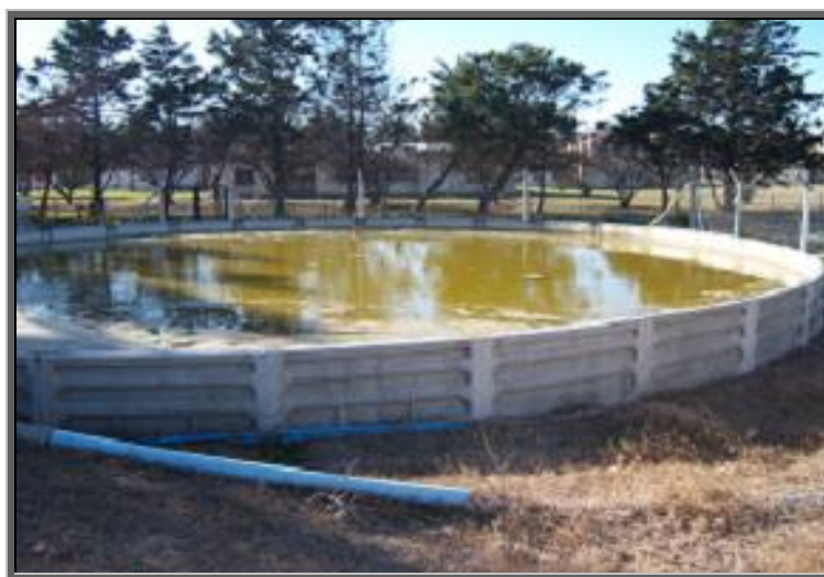
Figura 8: Laguna de maduración. UNRC. Río Cuarto-Córdoba.
