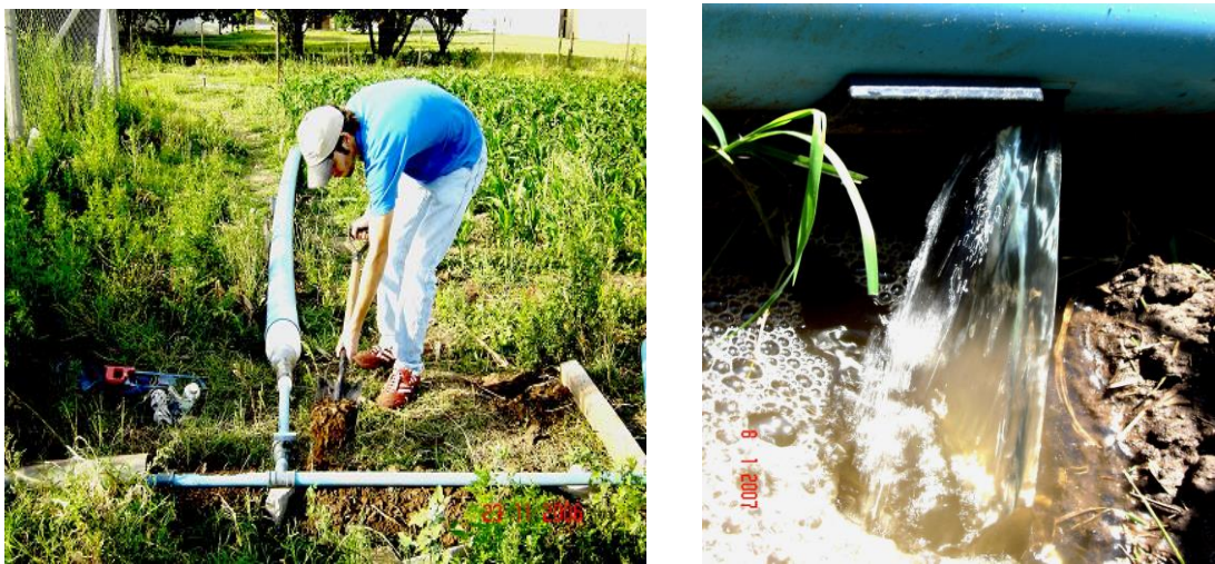
Figura 10: Colocación y ventanitas del sistema de riego. UNRC. Río Cuarto. Córdoba.
