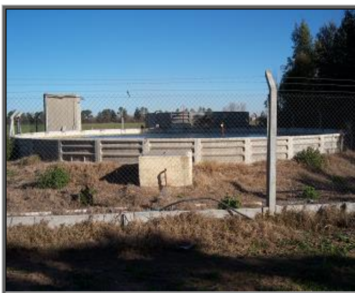
Figura 6: Planta experimental del primer tratamiento al agua residual. UNRC. Río Cuarto-Córdoba.
