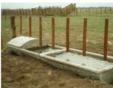
Foto 1. Bebedero de hormigón de dos cuerpos
