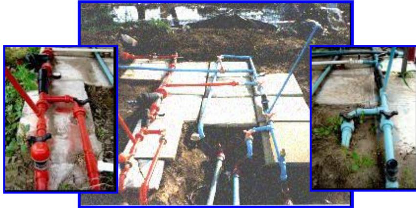
Figura 6: Centro de control del sistema de riego. UNRC. Río Cuarto. Córdoba.
