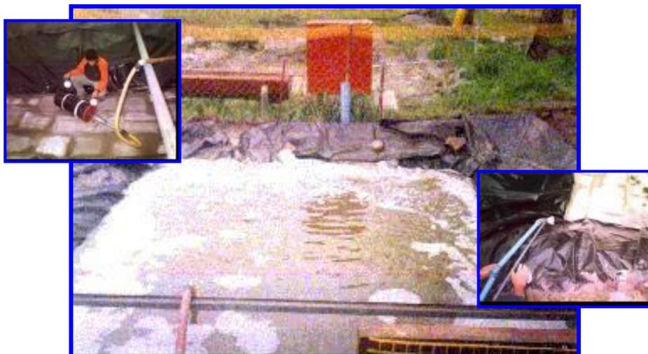
Figura 4: Reactor Biológico impermeabilizado con polietileno. UNRC. Río Cuarto. Córdoba.
