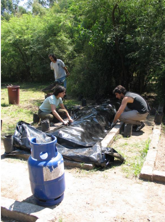
Fig.6 - Cierre hermético con túnel de polietileno.
